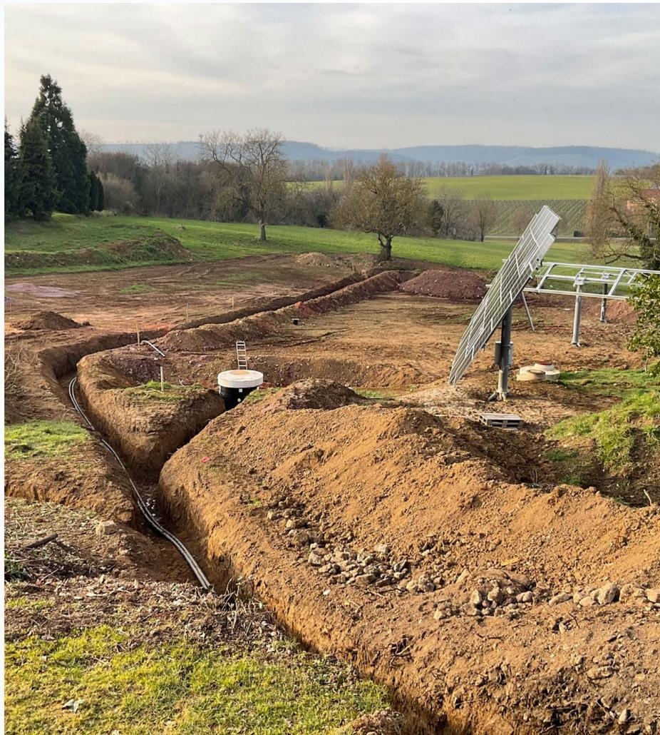
Um die Jahresarbeitszahl der zum Einsatz kommenden Wärmepumpen zu verbessern, wird das Erdreich durch Einsatz von Solarenergie außerhalb der Heizperiode um ein paar Grad höher aufgewärmt. Zu Beginn der Heizperiode sollte das Erdreich dann Temperaturen zwischen **15 °C** und **18 °C** aufweisen, gegen Ende der Heizperiode rechnen wir mit Temperaturen von **über 8 °C**.
